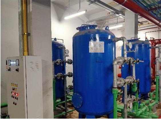
ระบบน้ำทิ้งที่ผ่านการบำบัดมารดน้ำต้นไม้
