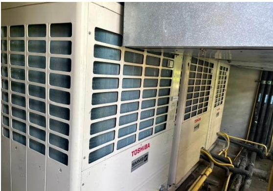
ระบบเครื่องปรับอากาศแบบ VRF
