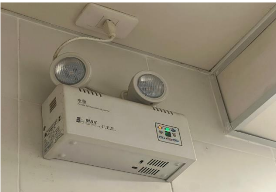
ไฟฟ้าส่องสว่างฉุกเฉิน
