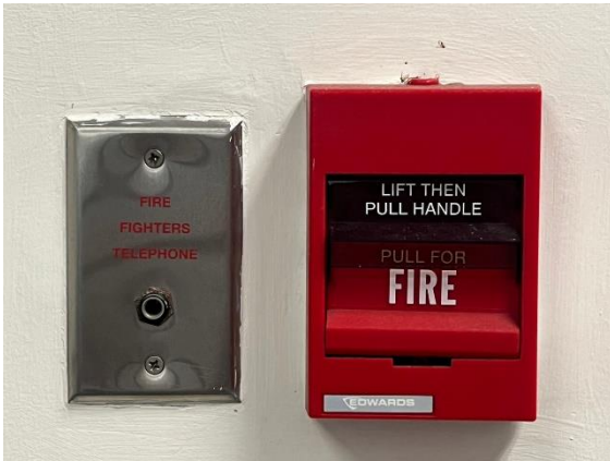
Telephone Jack และ Manual Station
