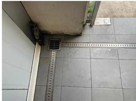
ท่อรับน้ำจากห้องพัสดุไปยังระบบบำบัดน้ำเสีย
